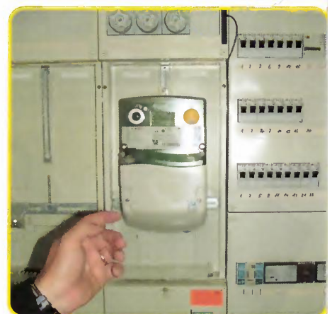
Le smart metering est un des plus puissants drivers du machine to machine. Ici, un « compteur » intelligent de Deutsche Telekom.
